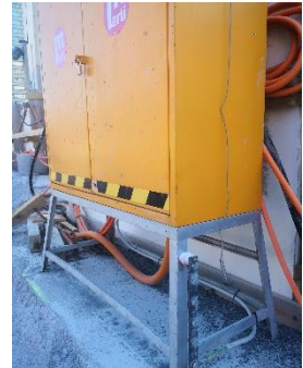
Abbildung 2: Quelle Firma Bau-Konzept
