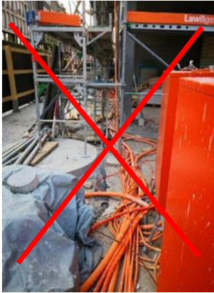
Abbildung 4: Quelle Firma Bau-Konzept
