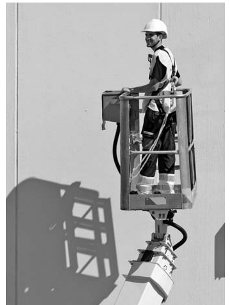
Bild 9: Auf Ausleger-Hubarbeitsbühnen müssen sich alle Personen mit Anseilschutz sichern. Achtung: nur die zugelassenen Anschlagpunkte verwenden und Halteseil möglichst kurz einstellen!
