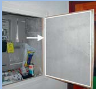
Asbesthaltige Brandschutzplatte
