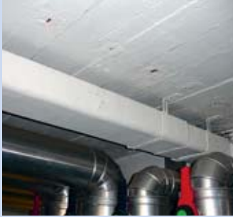
Kabelkanal aus Asbestzement
