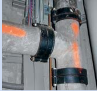
Asbestzementrohre
