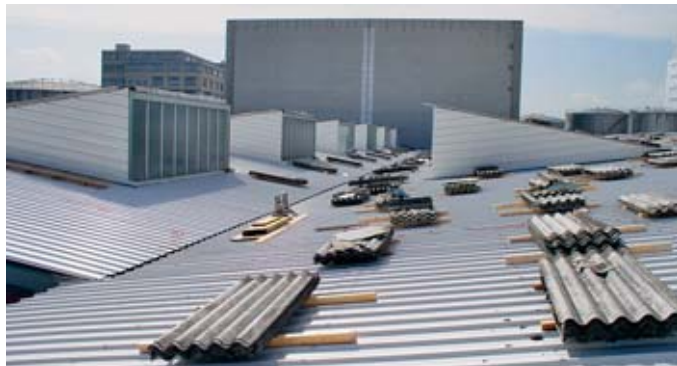
Asbesthaltige Wellplatten
