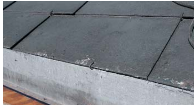
Asbesthaltige Schieferplatten
