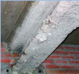
Spritzasbestisolation
