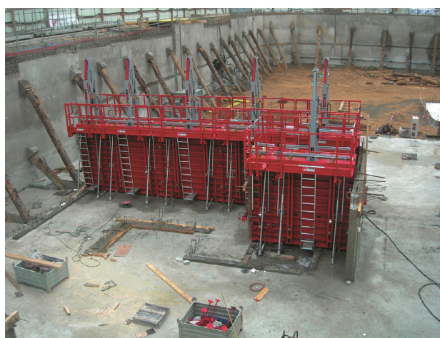
3 Wandschalung mit beidseitigen Betonierbühnen
