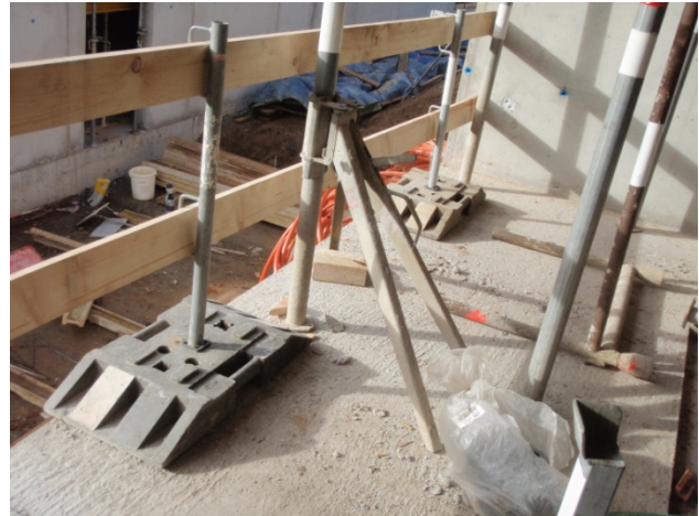
Bild 6 Gummisockel für den Seitenschutz an Deckenkanten sind verboten, weil der Seitenschutz leicht kippen kann.
