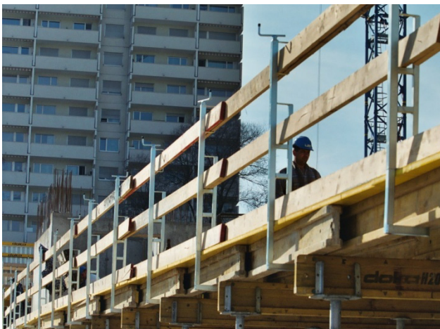
Bild 3 Seitenschutz mit Schutzgeländerzwingen
