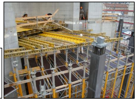
Konventionelle Schalung mit darunterliegendem Flächengerüst
