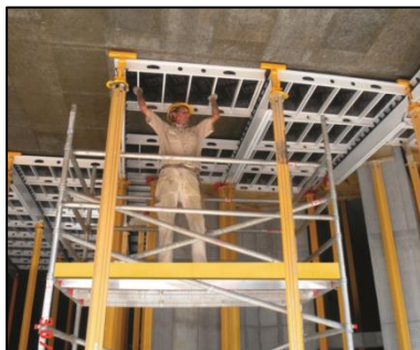
Ein- resp. Ausschalen von unten mittels Rollgerüst und / oder Kassettenschalung
